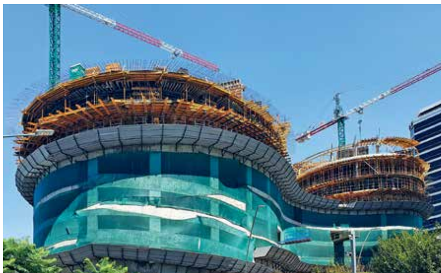
\ Edificio Infinity, Argentina
