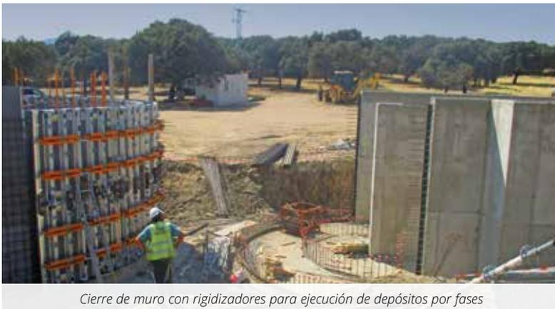
*Cierre de muro con rigidizadores para ejecución de depósitos por fases*
